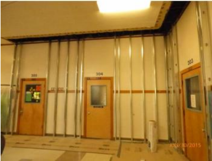
Llewellyn Seismic Framing
